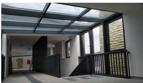
Tetősíkra átforduló függőnyfal Balatonfüred, Lóczy Lajos Gimnázium • 2020.
