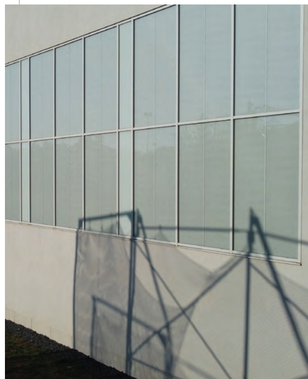
Hőhídmentes alumínium függőnyfal Okalux üveggel Veszprém, Tornász gyakorló • 2021.
