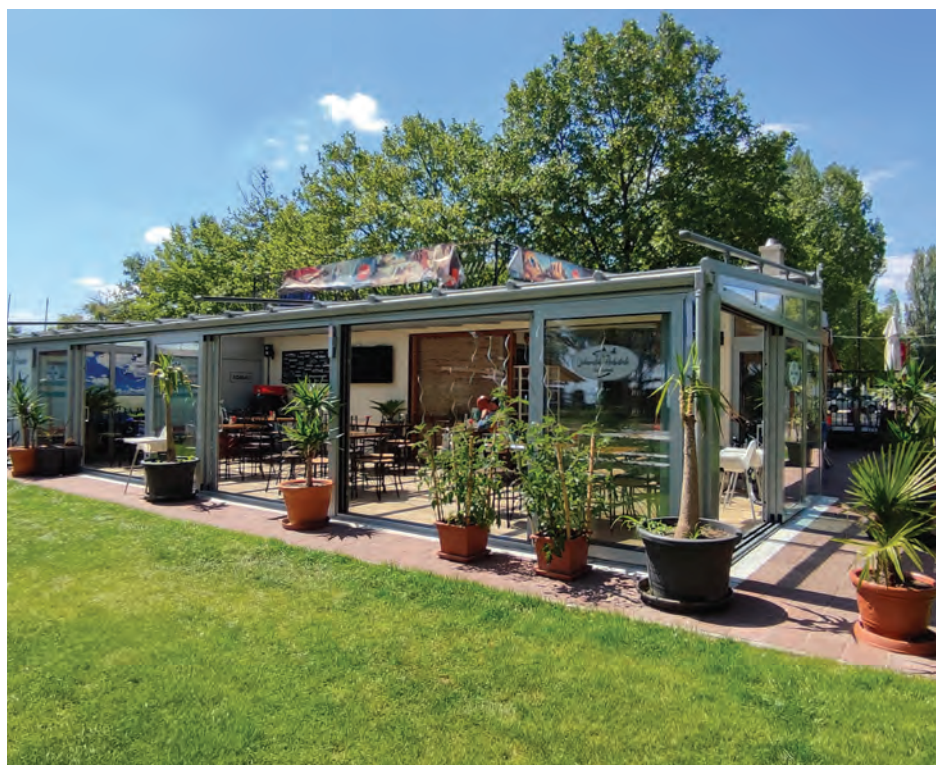
Alumínium szerkezetű télikert rendszer tolható szigetelt oldalfalakkal Balatonalmádi, Jóbarátok Halsütőde • 2020.
