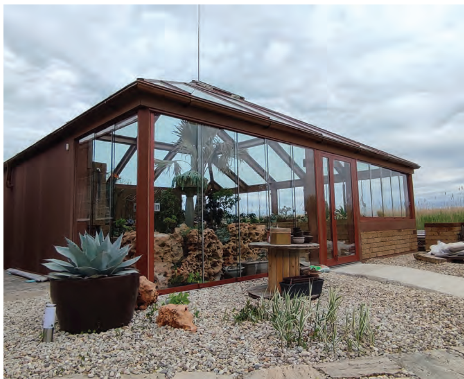
Meglévő acél váz szerkezet üvegfedése, tolható üvegajtókkal, alumínium bejárati ajtóval Paloznak • 2020.
