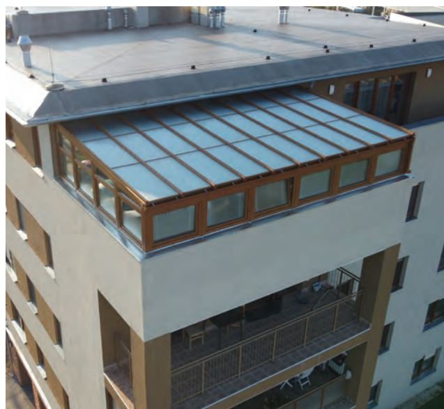
Hőhídmentes műanyag télikert homokfűvott üvegtetővel Veszprém • 2022.
