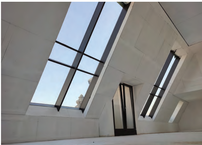
Tetősíkra épített hőhídmentes alumínium függőnyfal Budapest • 2021.
