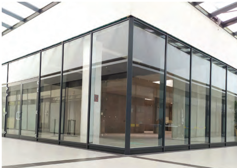
Hőhidas alumínium beltéri függőnyfal Budapest, autószalon • 2020.
